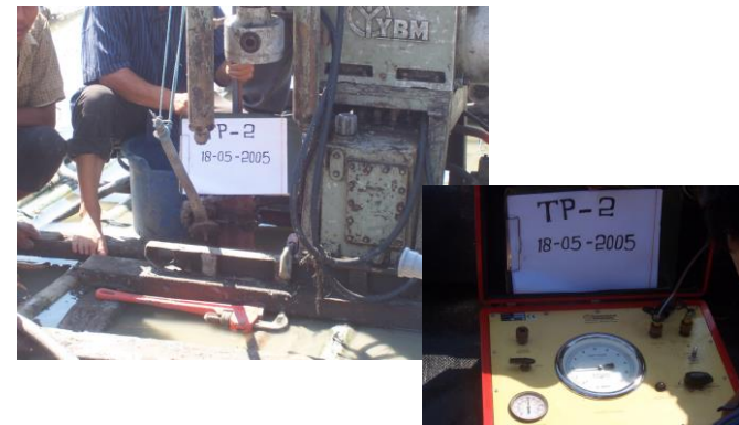
Pemasangan Piezometer dan tipe alat baca
